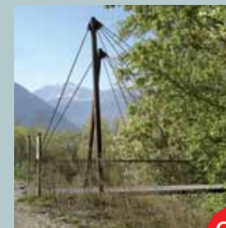
29 Jürgen Schäfer Italien «Schwebende Brücke» 2007
